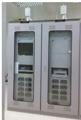
ระบบตรวจจับควันไฟ (ASD) และกล้องตรวจจับความร้อน
